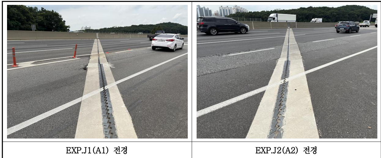
【사진 26.3.14】 신축이음장치 전경
