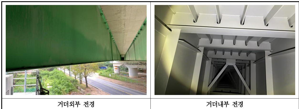
【사진 26.3.4】 거더 전경
