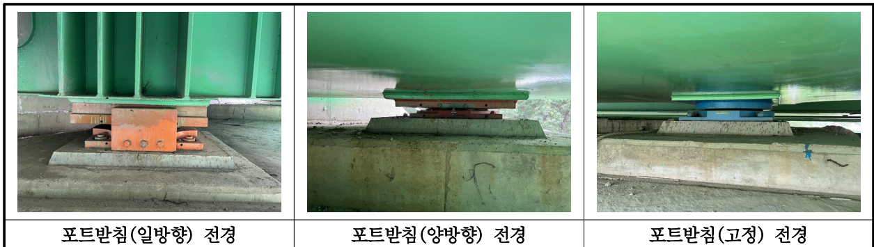
【사진 26.3.10】 교량받침 전경
