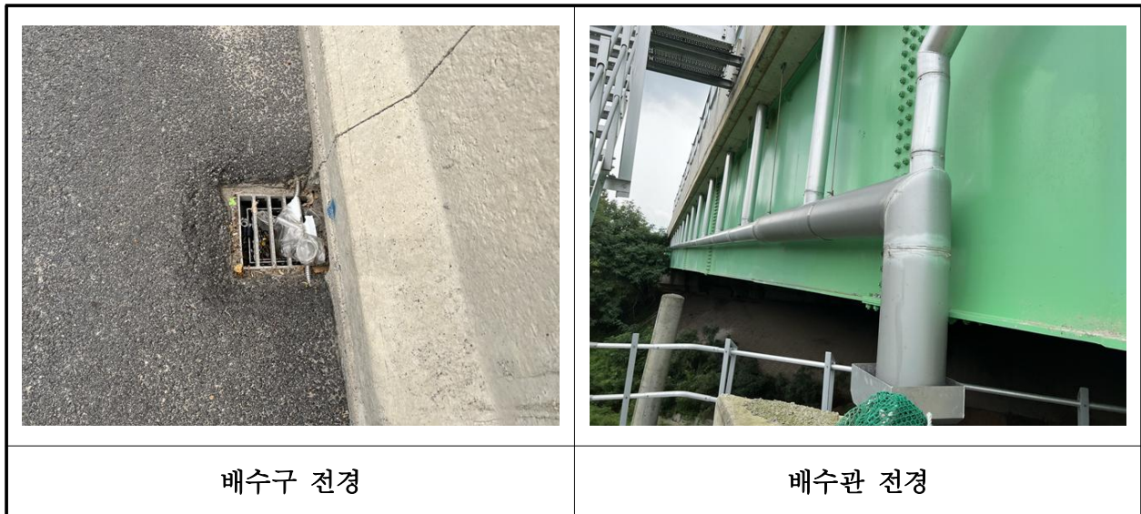
【사진 26.3.19】 배수시설 전경
