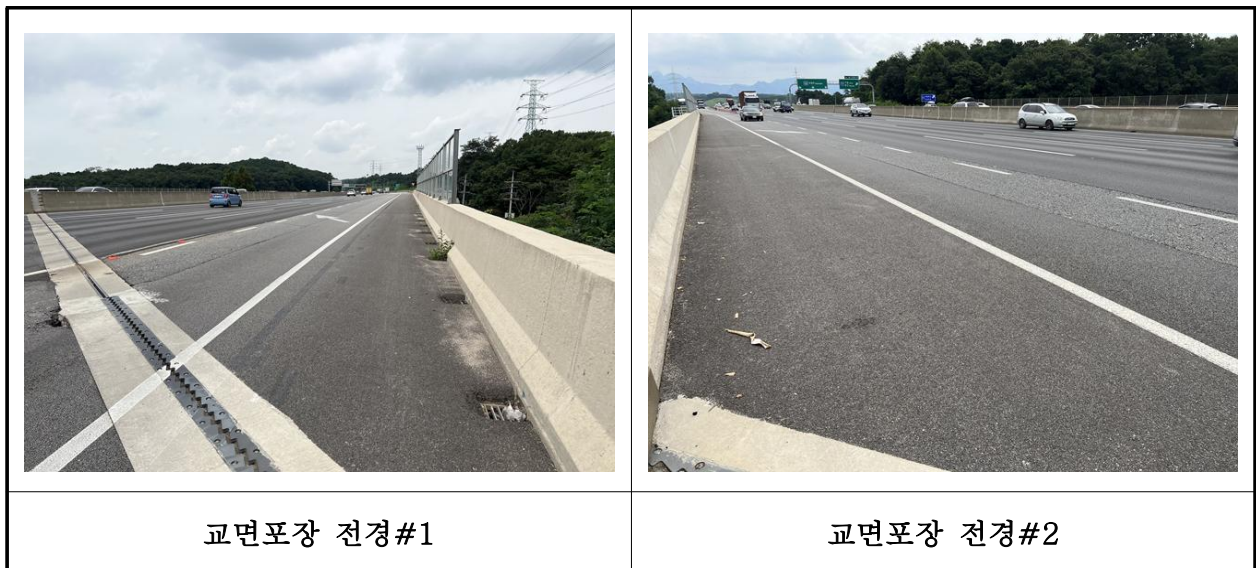
【사진 26.3.17】 교면포장 전경
