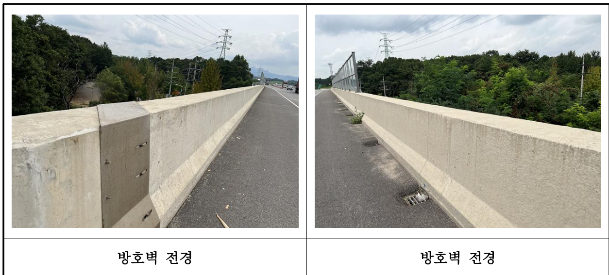
【사진 26.3.21】 방호벽 전경
