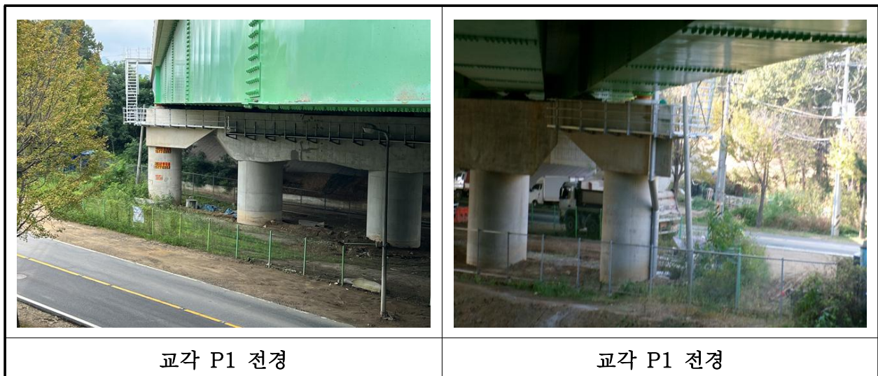
【사진 26.3.8】 교각 전경
