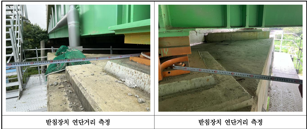
【사진 26.3.12】 교량반침장치 연단거리측정
